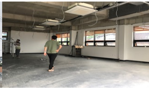
침산 커뮤니티센터 2층 (공사중)
