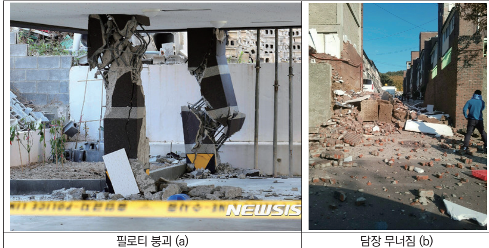
그림 4-26 | 포항시 지진피해 사례
