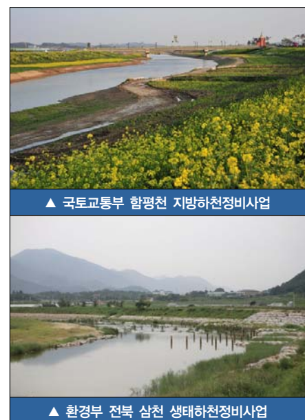
그림 1 국토교통부와 환경부의 하천정비사업 완공 후 전경
