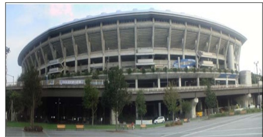
그림 2 일본 요코하마 쓰루미 강변의 닛산스타디움 (필로티 구조)
