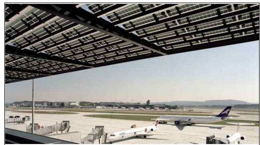
[그림 7] 취리히공항 터미널 태양광발전 지붕
