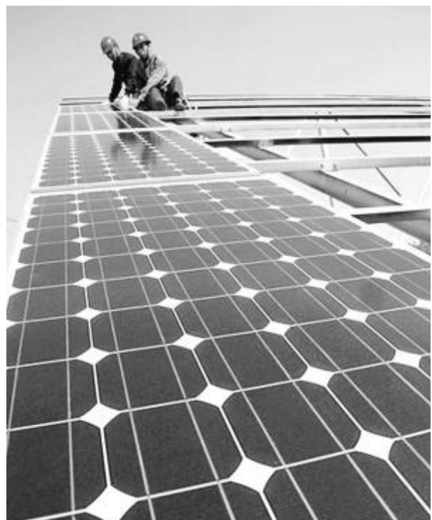
【그림 3】 태양열 집광판 시공모습
