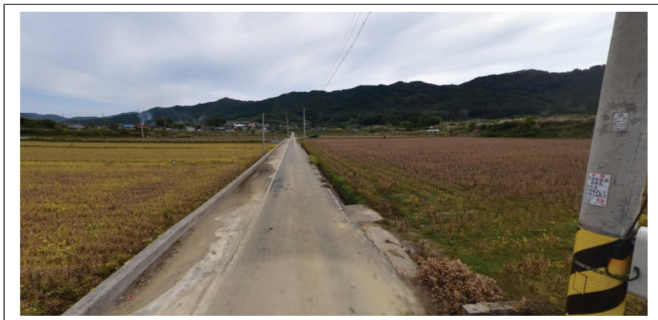
그림 4-5 | 도로 길가장자리의 연석이 설치된 모습
