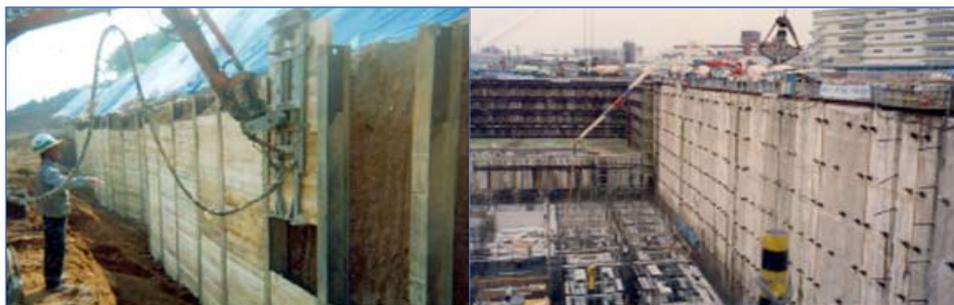
주: H-pile 및 토류판 공법은 H 모양의 말뚝을 1-2m 간격으로 지중에 설치하고, 말뚝 사이에 흙막이용 두꺼운 판자(토류판)를 설치하여 토사의 붕괴 및 토압을 지탱하는 것으로, 흙막이 공사에서 가장 많이 사용되고 있는 공법임. 지하연속벽 공법은 수직으로 땅을 판 후, 흙이 무너지지 않는 데 도움을 주는 안정액과 콘크리트를 혼합하여 연속적으로 철근콘크리트 벽체를 시공하는 것(이종호 2009)
