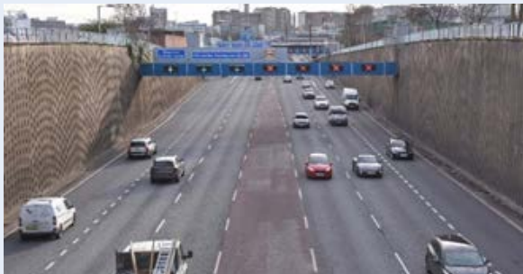
〈그림 2〉 버밍엄 애스턴 고속도로(Aston expressway) 녹색 벽 설치 전 · 후
