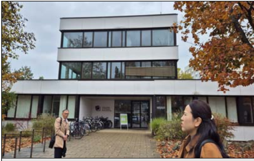
▲ IOER 건물 전경
