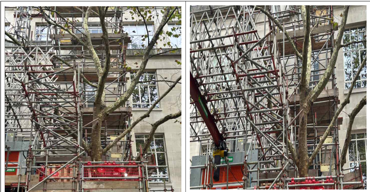
<런던 건축물 공사시 수목보전 사례>
