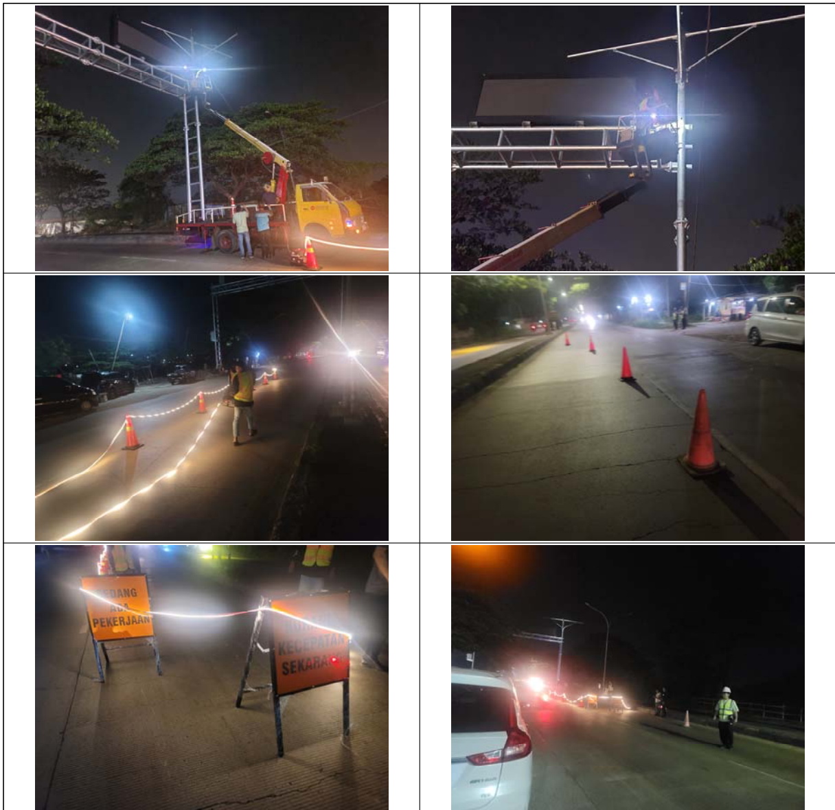
<그림> 공사중 교통 처리 대책 점검
