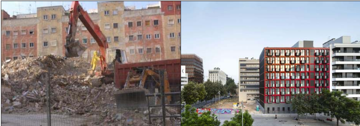
▲ (좌)바르셀로나 북부 Turó de la Peira 지역의 알루미늄노시스 주택단지 철거현장 (2002)7) (우)APROP Glories 외부전경(자료:바르셀로나 시청 (Ajutament de Barcelona))
