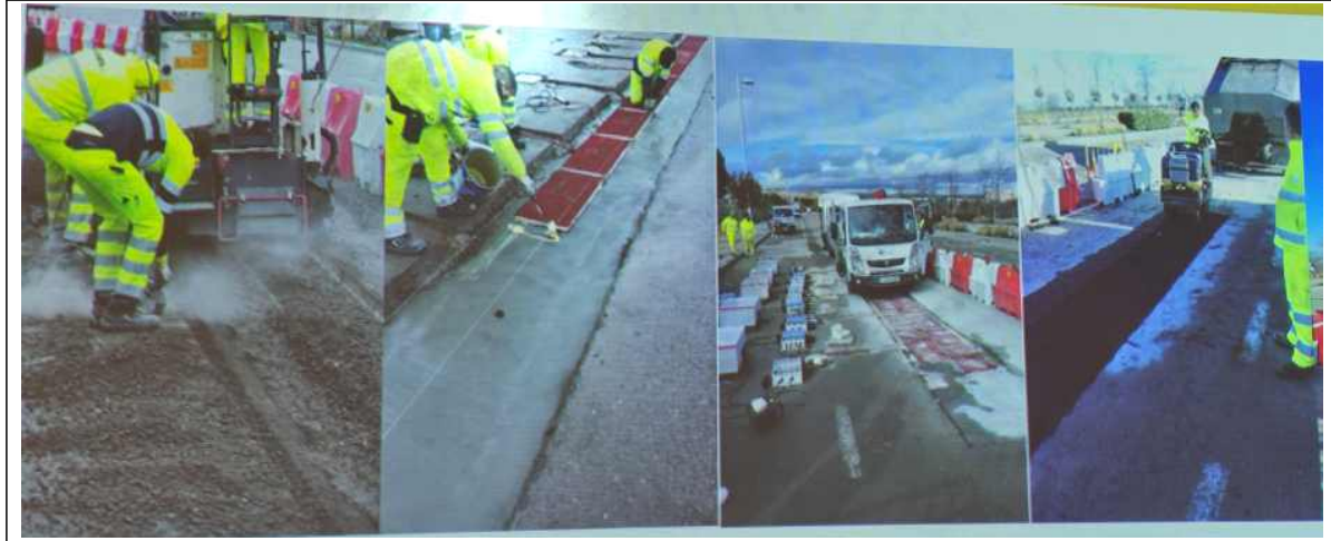
<전기화 포장 시험 구간의 건설 및 평가>
