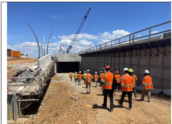
▲ 알링턴 국립묘지 지하터널부 공사현장
