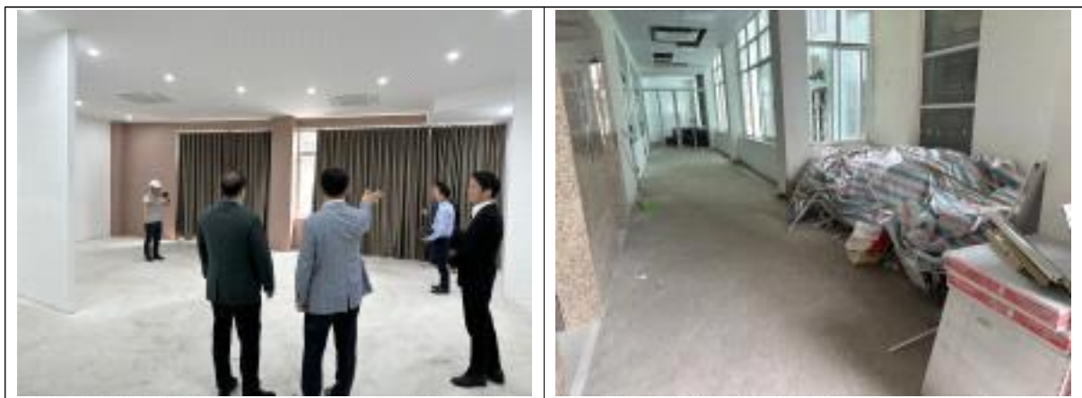
AMC 내 기술전시관 공사현장 점검
