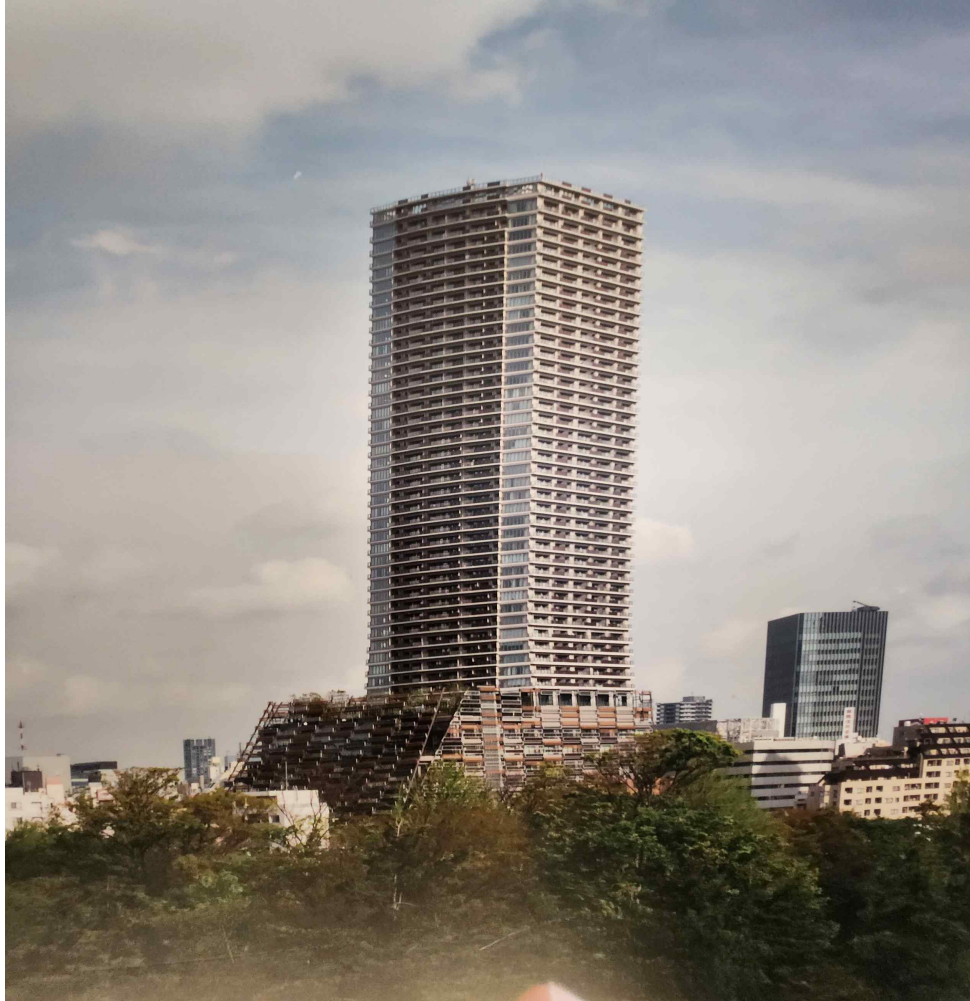
[사진 4] 일본 경의 대표적 그린빌딩 토시마 사무용 빌딩전경
