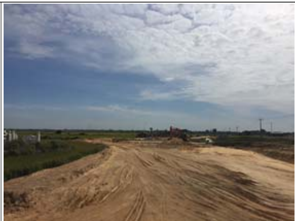
【도로 건설 중인 모습】
