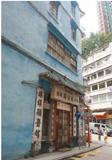
타임쿠폰샵 전경. 샵이 위치한 블루하우스는 100년도 더 된 건물로 정부가 철거하려던 것을 주민의 힘으로 지켜낸 상징적인 장소 중 하나
