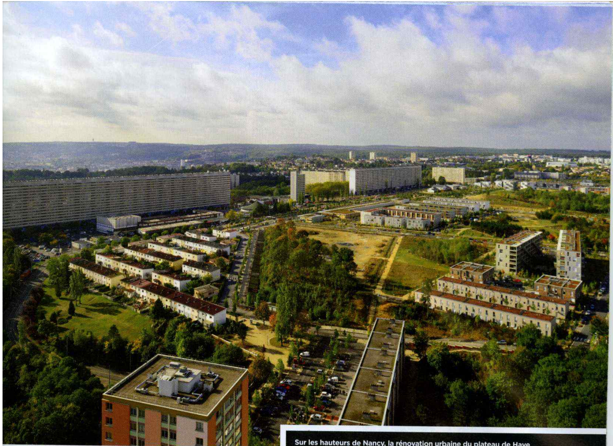
Sur les hauteurs de Nancy, la rénovation urbaine du plateau de Haye et de ses deux emblématiques barres du Cèdre bleu et du Tilleul argenté compose avec les qualités du site, dans la trame forestière préexistante.
