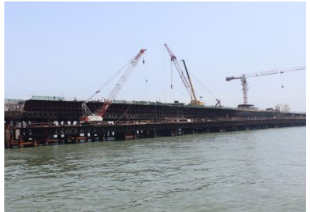
<해상교량 시공 전경>
