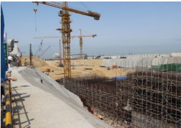
<인공섬 내 도로BOX 시공 전경>
