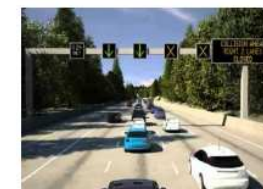
LCS (Lane Control System)
